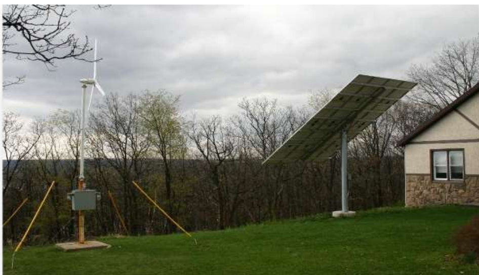
Rys. 18.6 Elektrownia wiatrowa zasilająca budynek na kampusie sprzężona z elektrownią słoneczną
