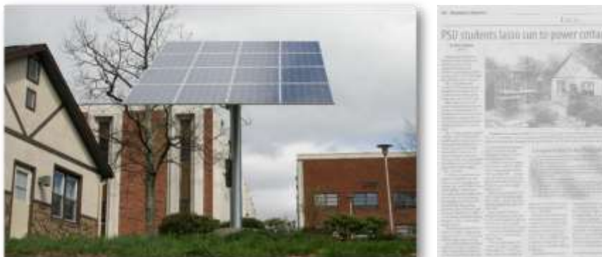
Rys. 18.2 Słoneczna elektrownia o mocy 4.8 kW zasilająca mały budynek na kampusie uniwersyteckim oraz informacje prasowe
