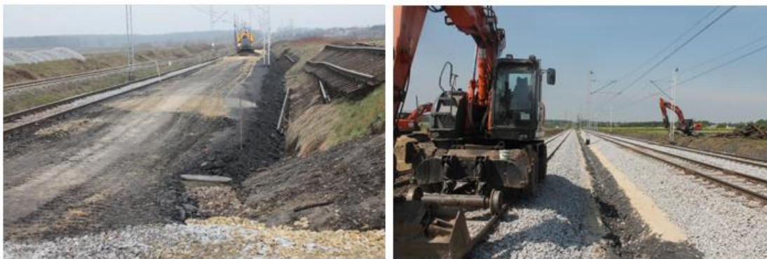
Rys. 3 Zastosowanie kruszyw górniczych, Linia kolejowa 149, Knurów, 2021/2022
