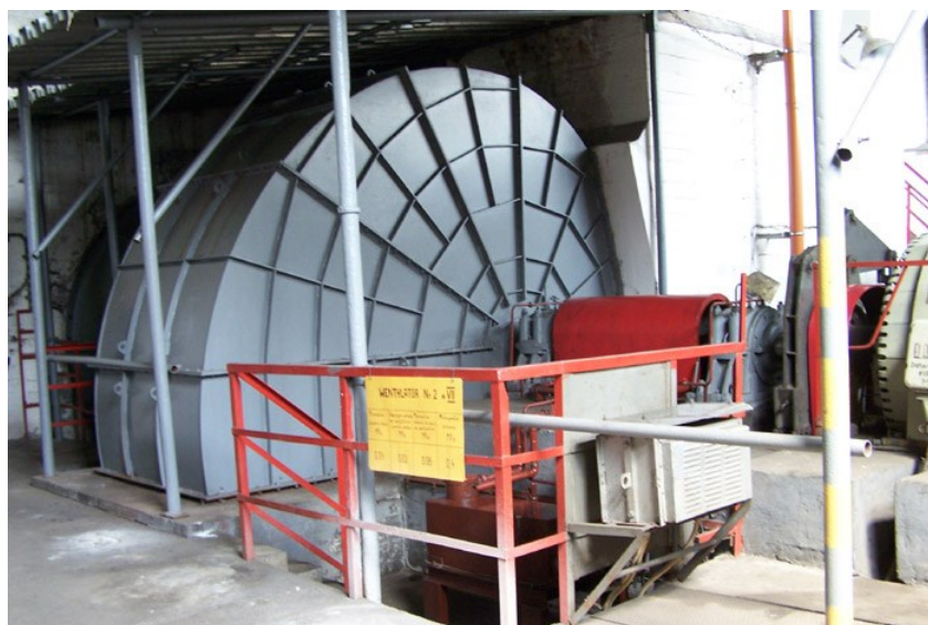
Rys. 24.4 Wentylator typu WPK-3,3 przy szybie VII KWK Chwałowice
