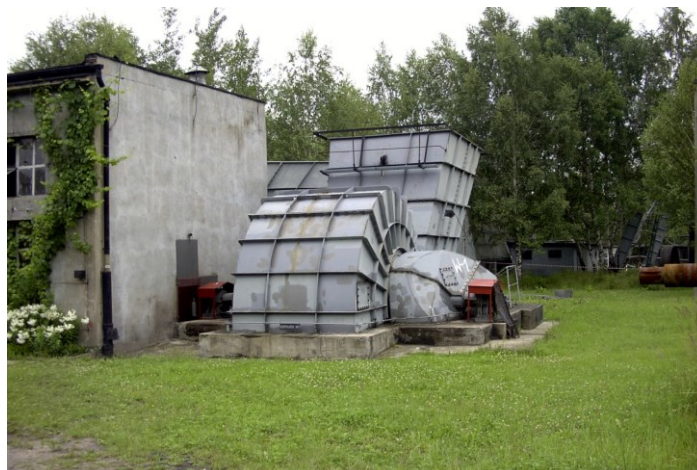
Rys. 24.3 Wentylator typu WPR-1,8 przy szybie V KWK Chwałowice
