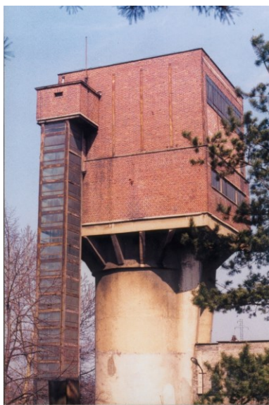
Rys. 24.2 Szyb IV KWK Chwałowice
