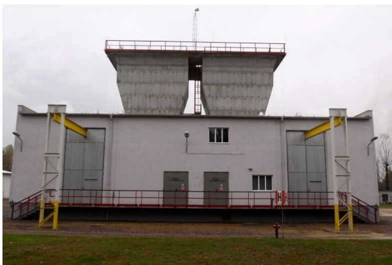
Rys. 24.5 Nowa stacja wentylatorów głównych przy szybie V KWK Chwałowice
