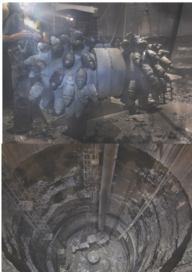
Rys. 12.3 Kombajn urabiający, przy budowie zbiornika retencyjnego KWK Pniówek
