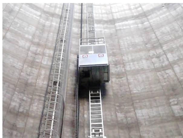
Rys. 12.9 Widok urządzenia dostępowego
