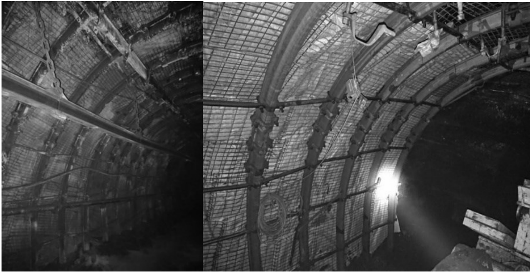
Rys. 3 Fotografie przedstawiająca sposób wykonania opisanej profilaktyki w chodniku wentylacyjnym Z-11 w pokł. 408/1
