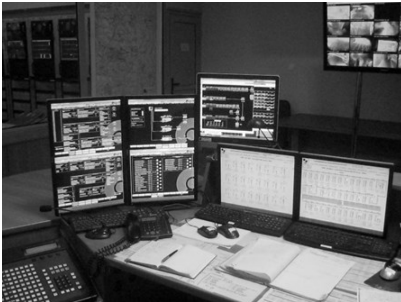
Rys. 18 Dyspozytornia zakładowa Ruchu Jastrzębie. Miejsce pracy dyspozytora energomaszynowego. Stanowisko wizualizacji i parametryzacji systemów EH-MineView, EMAC, SAURON, ZEFIR
