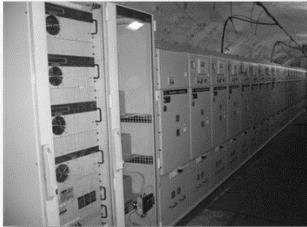
Rys. 2 Zmodernizowana rozdzielnia
