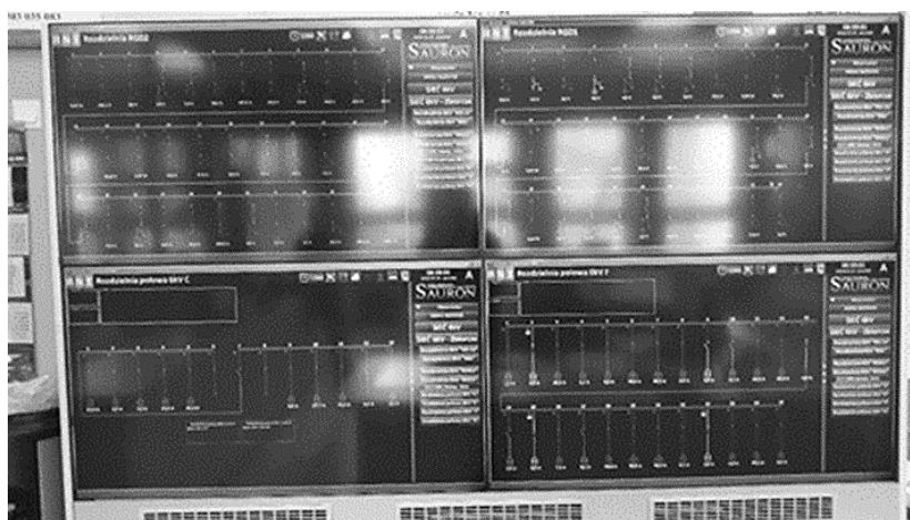
Rys. 5 Widok rozdzielni 6 kV w systemie SAURON na stanowisku dyspozytora energomaszynowego w Ruchu „Zofiówka”
