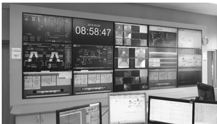
Rys. 19 Dyspozytornia zakładowa Ruchu „Zofiówka”. Miejsce pracy dyspozytora energomaszynowego. Stanowisko wizualizacji i parametryzacji systemów Kopex, SAURON, ZEFIR
