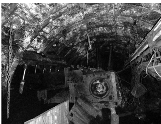
Rys. 4.11 Widok skrzyżowania ściana-chodnik w chodniku II w obudowie podporowej przykotwionej
