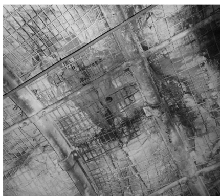
Rys. 4.4 Widok wlotu otworu badawczego w chodniku I
