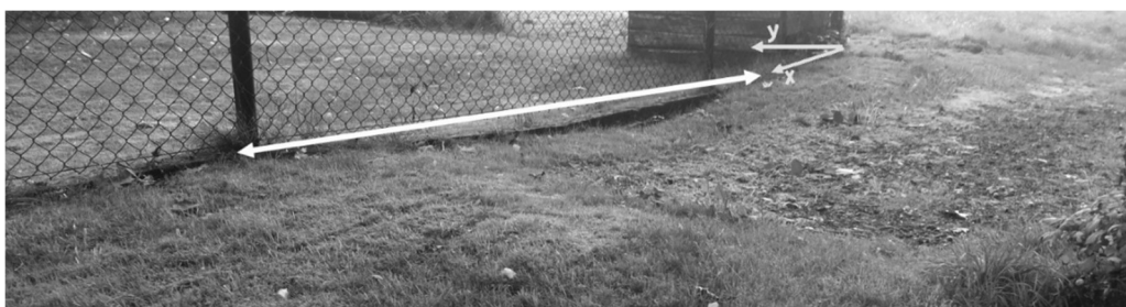
Rys. 22.3 Deformacje powierzchni od strony południowej
