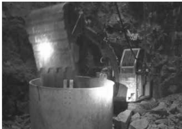
Rys. 12.3 Widok wielofunkcyjnej koparki szybowej DH EQ 200 podającej urobek do otworu wielkośrednicowego
