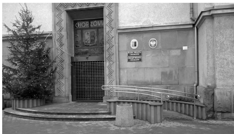
Rys. 21.2 Wejście dla niepełnosprawnych
